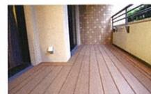
100%リサイクル商品のため環境にもやさしいニス塗りを不要で、長期間美しさを持続できる「Geo Deck」。木粉を一切使わず、代わりに製紙工場(セルロース)廃棄物を利用しているため、よくあるウッドデッキに比べ色褪せ・劣化しにくいのが特長だ。また、もみ殻を入れることで耐摩耗性をアップ。さらに商品完成後85℃の温度で48時間熱入れを行い、太陽光にさらされても変色しにくいようしている
